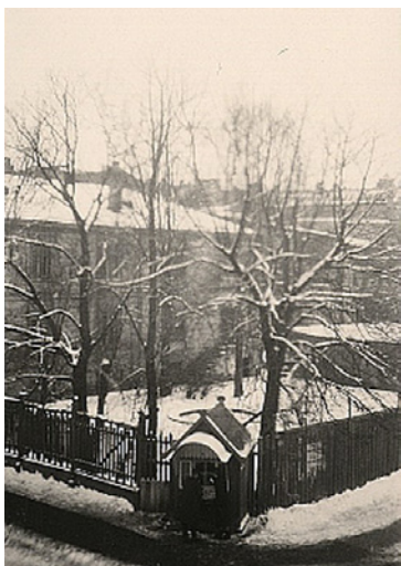
10. attēls. Grunts gabals Dzirnavu un Strēlnieku ielas stūrī (adrese – Dzirnavu ielā 16). Priekšplānā – E. Arnāla bijušais minerālūdeņu iestādes dārzs ar strūklakas atliekām. 20. gadsimta 30. gadi.
